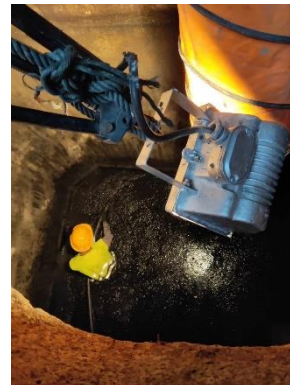
รูปที่ 28 เจ้าหน้าที่ตัดไขมันออกจากท่อ
